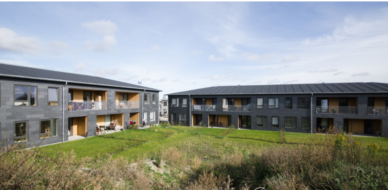
De renoverede blokke på Ravnkildevej
